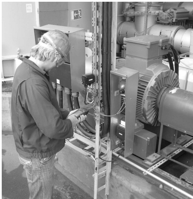
Bild 2: Erfassung von Instandhaltungsinformationen unter Einsatz der RFID-Technologie.
