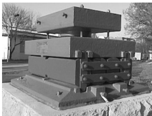
Originallager der Friedrich-Ebert-Brücke Magdeburg (heutige Sternbrücke): Einbauzeit 1918-2000, Rekonstruktion 2000, Verstellbereich 12 cm, Eigengewicht 6,8 t
